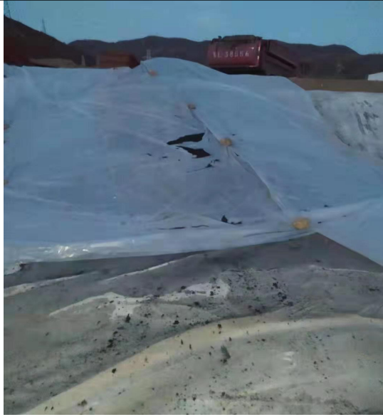
临时渣场灰渣堆体的苫盖
