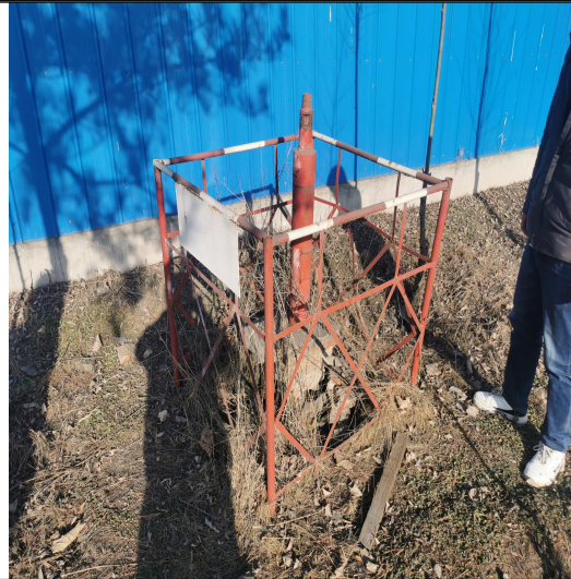
渣场下游地下水监测井（原有）
