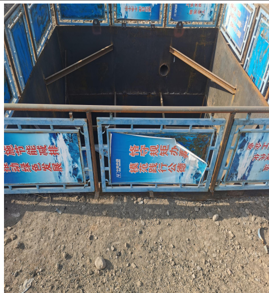
钢制渗滤液收集池
