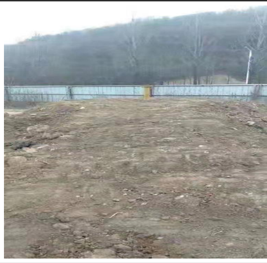
渣场上游地下水监测井（新建）
