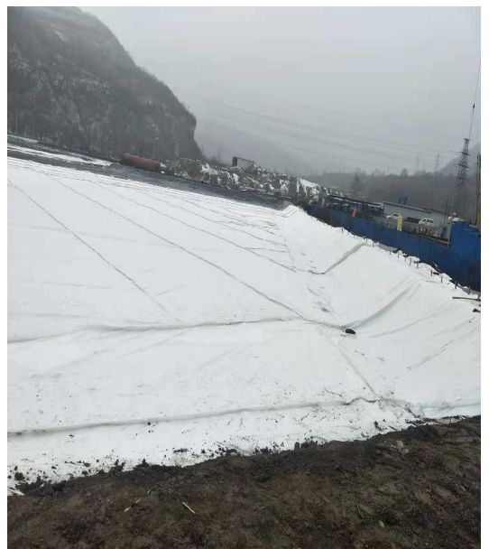
临时渣场建设后占地范围现状
